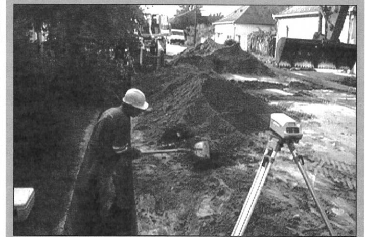
A szennyvízesatorna hálózat építési munkái jelenleg a Kossuth, az Úttörő, a Bajcsy utcában folynak. Az 54-es főúton a Keceli utca, valamint a Bajai utca egy-egy szakaszának lezárása okoz némi kellemetlenséget, a forgalom lassulását.
