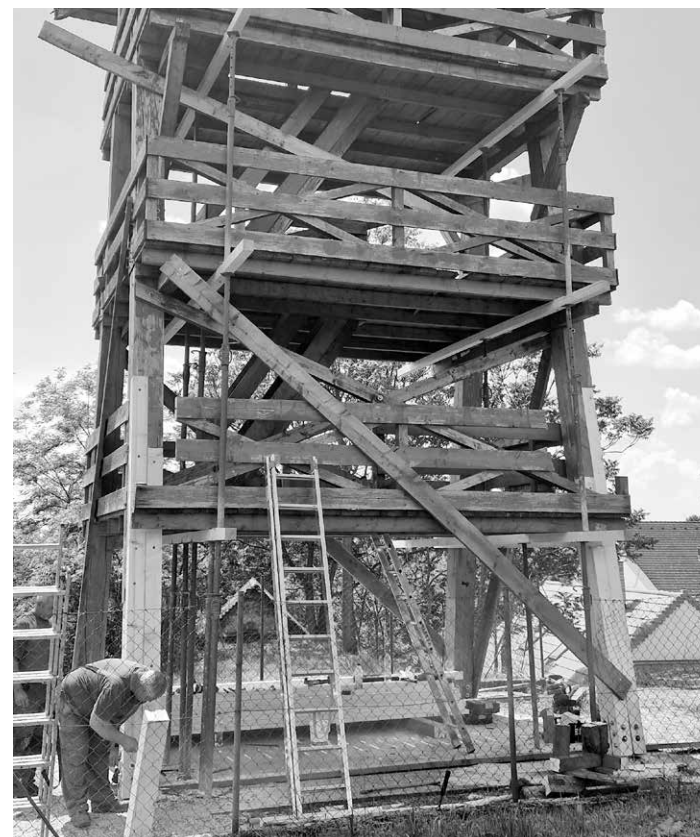
Megkezdődött a kilátó felújítása
