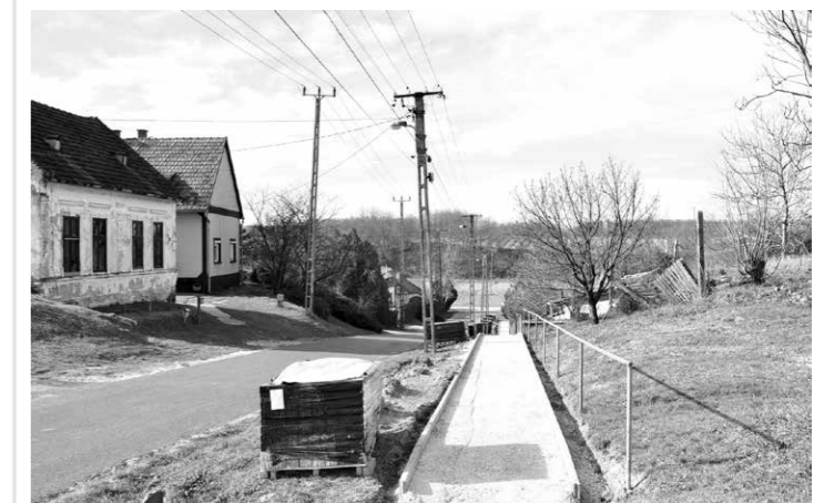
Megkezdődött a Halasi-hegyi feljáró felújítása
