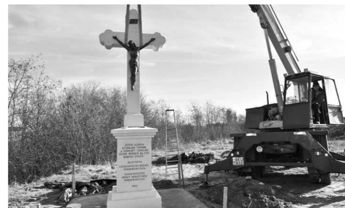
Keresztállítás a Kecel felé vezető úton
