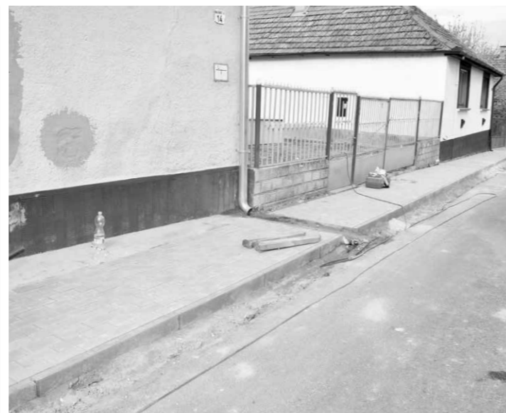
Járda felújítás a Bajtárs utcában. A Magyar Falu program keretében folytatódik a járda felújítás Császártöltésen.
