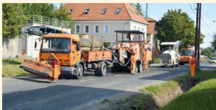
Az 54-es főút belterületi szakaszának felújítása
