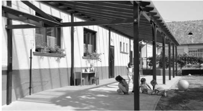
Elkészült az óvoda udvarán a tágas és nagyon szép terasz, így esős időben is kimehetnek a kicsik a levegőre valamint a játékokat is lehet itt tárolni. Örömteli évkezdést és évet kívánunk a császártöltési óvodásoknak és az ott dolgozóknak!
